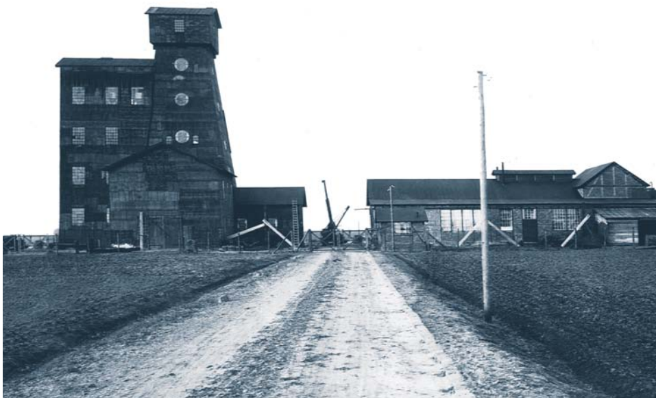
Abteufgerüst von Schacht Friedrichsfeld bei Wesel im Jahr 1914
