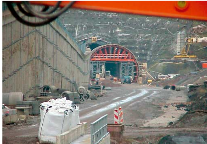
Der Egge-Tunnel wird im Ulmenstollenverfahren in den Berg getrieben.
