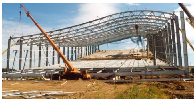
Die erste Indoor-Skihalle Deutschlands auf der stillgelegten Deponie Neuss-Grefrath im Rohbau
