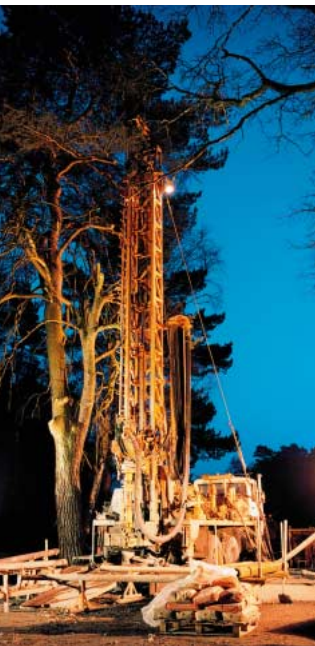
Rund um die Uhr wurde auf dem Golfplatz bei Bergisch Gladbach-Refrath gebohrt.
