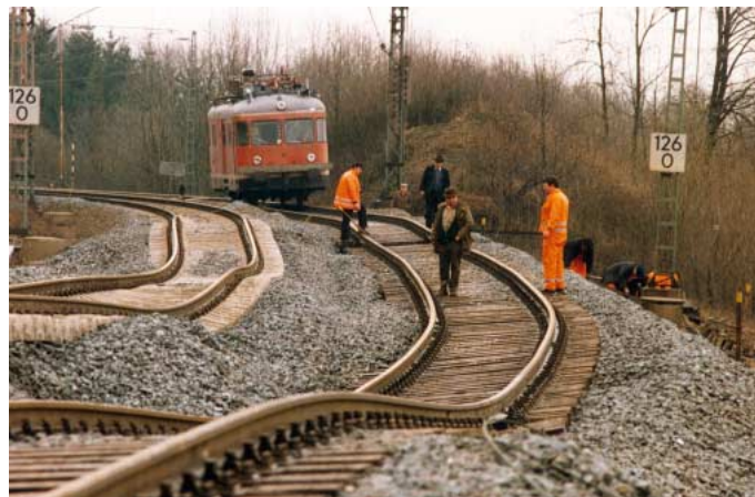
So wurden die Gleise der Bahnstrecke Kassel – Paderborn durch eine Hangrutschung am Paderborner Berg verbogen.
