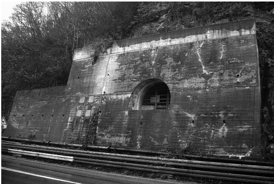
Abb. 4 Hohenlimburg-Oege: Durch Felssicherungsmaßnahmen umgestalteter Eingangsbereich der Oeger Höhle
