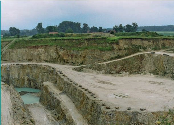
Abb. 12: Grundwassergewinnung im Kalkstein-Abbaubetrieb
