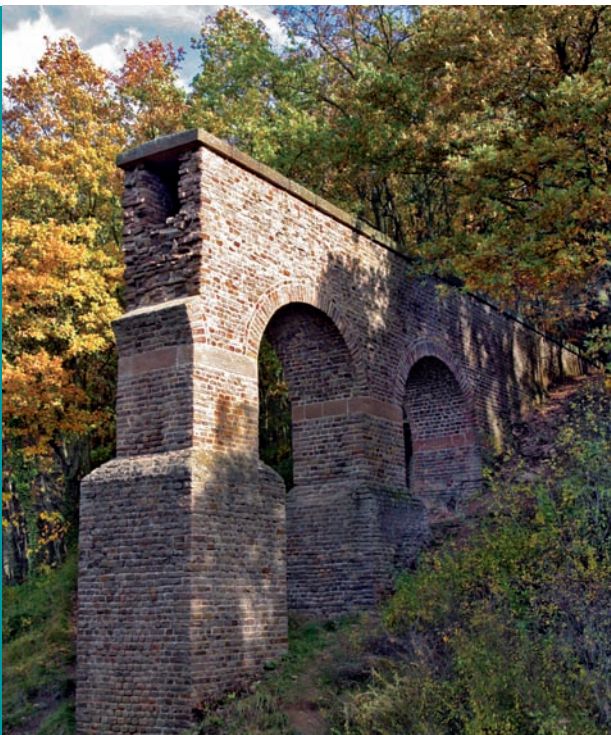
Abb. 8: Aquädukt von Vussem (Rheinland) der römischen Wasserleitung nach Köln
