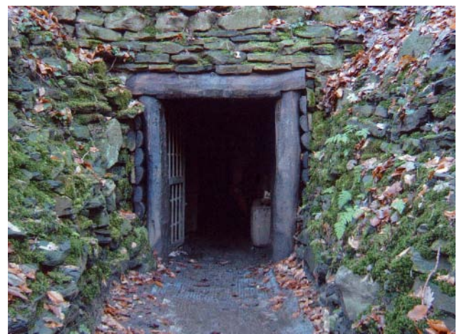
Abb. 194 Mundloch des Förderstollens Schleifmühle mit Kaschierung der Ausmauerung durch denkmalgerechte Türstücke aus Holz
