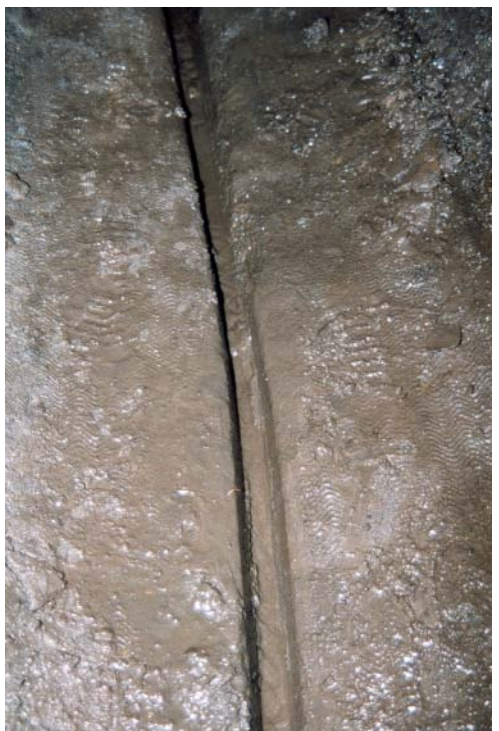
Abb. 149 Förderrille in der „Fuchsbaustrecke“ von Nordosten gesehen
