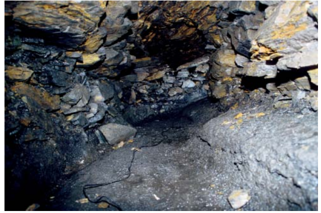
Abb. 115 „Sumpfstrecke“ mit Bergemauern vor Ort, eine frühere Förderstrecke
