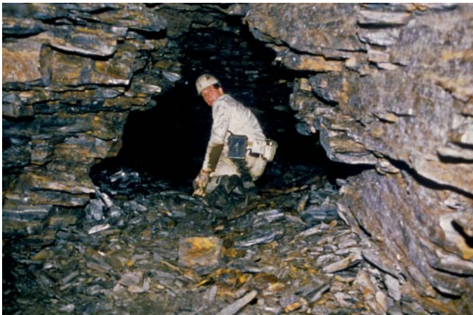
Abb. 53 Bergseitiges Ende des Stollens Graf Wittekind Nr. 4: teilweise verbrochener Förderberg
