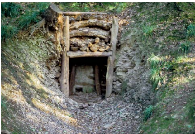
Abb. 102 Provisorischer Mundlochausbau des Stollens Graf Wittekind Nr. 2, 1997
