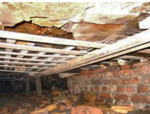
Abb. 134 Das Flacheisengeflecht zur Sicherung des Hangenden
