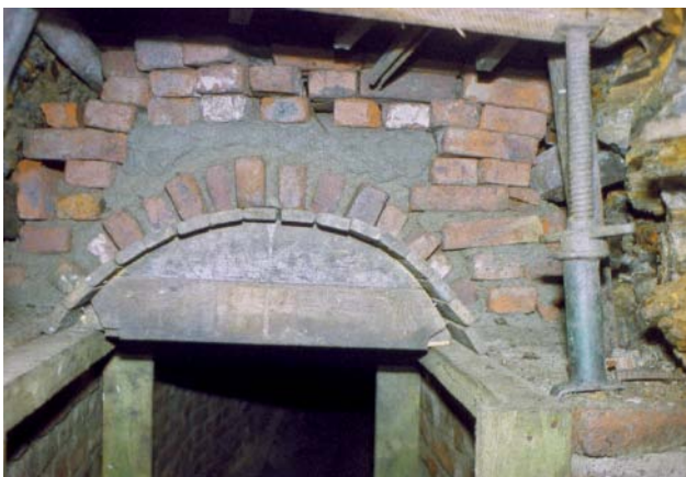
Abb. 141 Lehrgerüst für das Firstgewölbe
