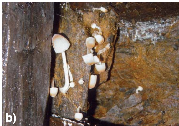
Abb. 155 Pilzbefall am Grubenholz a) gelbe Pilze b) weiße Pilze
