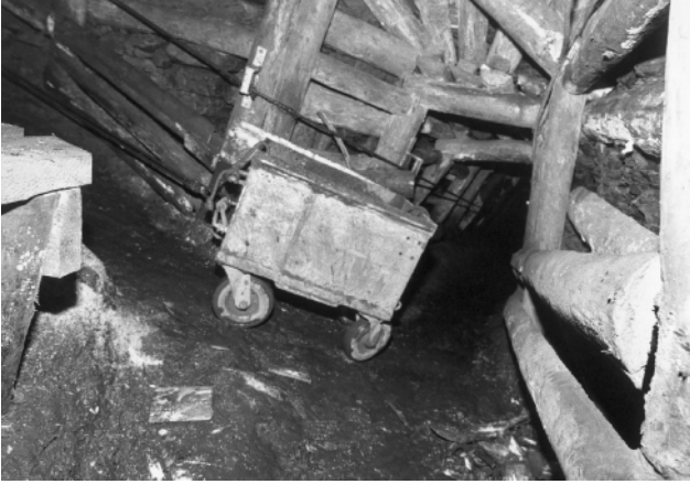
Abb. 172 Wagenführung in der Kurve zur Abbaustrecke nach Süden
