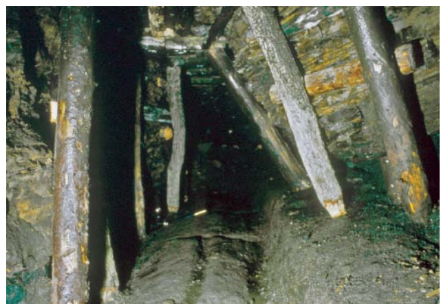
Abb. 95 Abkantung mit Förderrillen und Schwellenvertiefungen in der Abbaustrecke nach Nordosten
