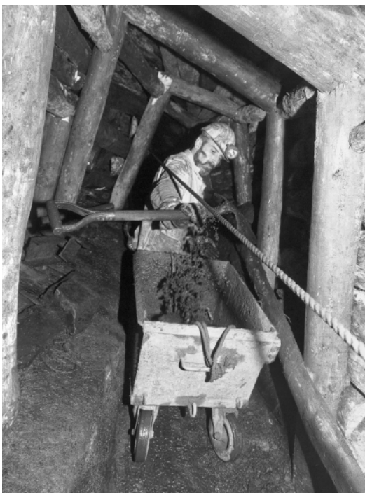
Abb. 170 Ein Förderwagen in der Abbaustrecke nach Süden
