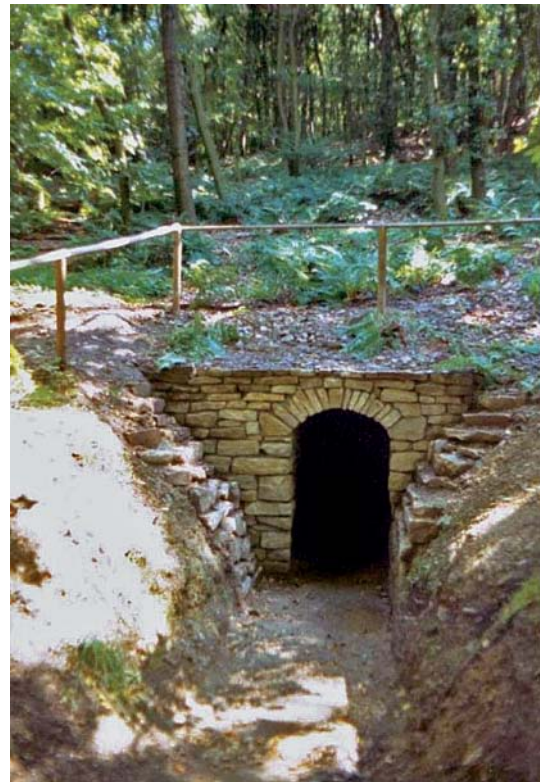
Abb. 55 Fertiggestellter Stollenvorbau des Stollens Graf Wittekind Nr. 4
