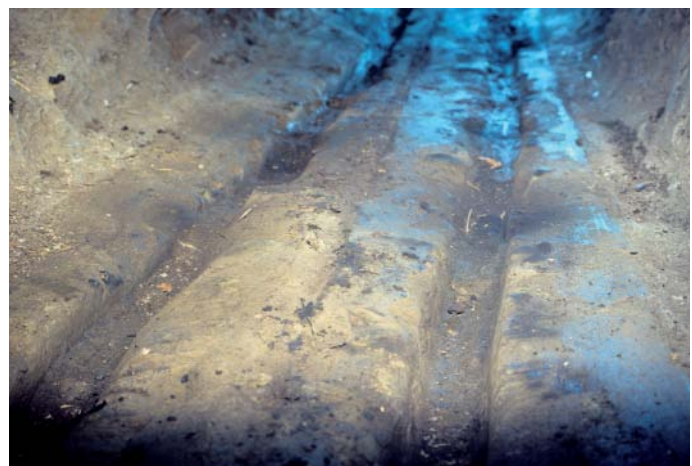
Abb. 69 Förderrillen im Stollen (mit Mittelspur vom Zugseil?)
