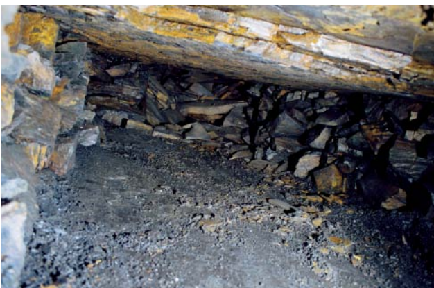
Abb. 86 Verbrochener Bremsberg „w“ vor Ort
