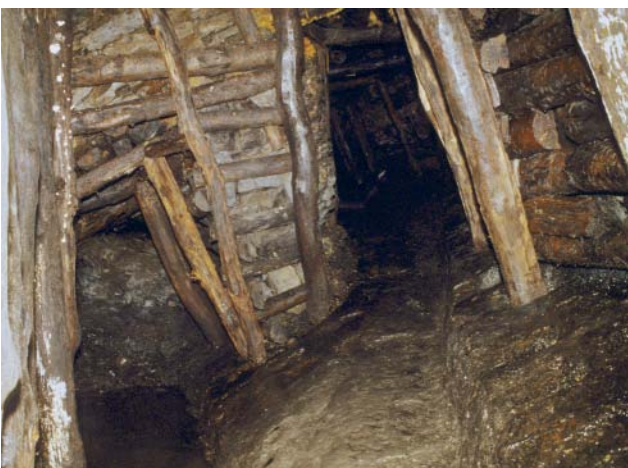
Abb. 82 Abzweig in der Abbaustrecke nach Nordosten
