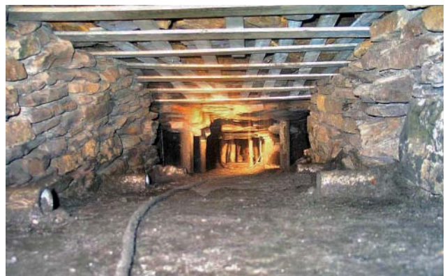
Abb. 135 Bruchsteinmauern zur Kaschierung der Ziegelsteine und Rohrstücke als Steighilfen im Übergangsbereich Verbindungsaufhauen/Förderstollen Graf Wittekind
