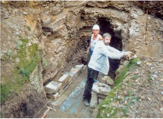
Abb. 70 Freigelegtes festes Gebirge am Mundloch, Beginn der Mauerung
