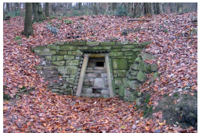
Abb. 103 Erneuerter Vorbau des Stollens Graf Wittekind Nr. 2, 2005
