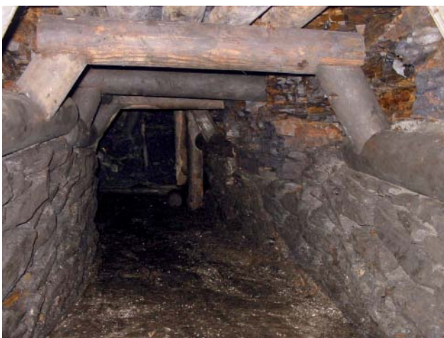
Abb. 90 Verbindungsberg zwischen der Förderstrecke Schleifmühle „u“ und der Abbaustrecke Graf Wittekind „r“
