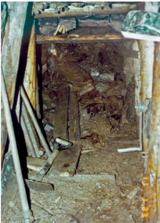
Abb. 107 Vorläufige Sicherung des Mundlochs
