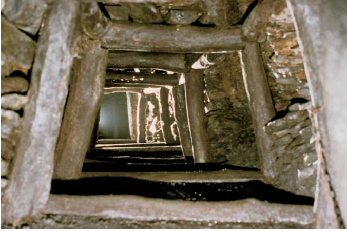
Abb. 136 „Verbindungsaufhauen“ nach Demontage der Rutschen
