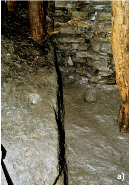
Abb. 62 Abkantung einer den Förderberg kreuzenden, älteren Strecke: a) Blickrichtung aufwärts b) Blickrichtung abwärts
