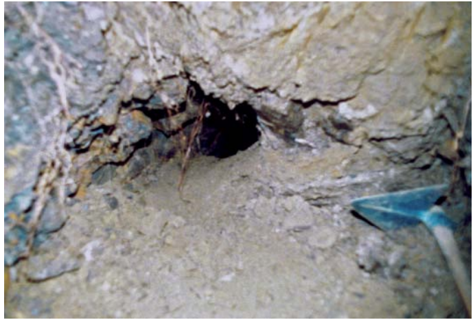
Abb. 106 Das Grubenwetter freigebende (ausblasende) „Mückenloch“
