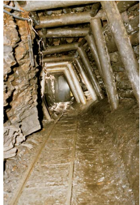
Abb. 79 Mehrfach erneuerter Ausbau in der Abbaustrecke nach Nordosten, 2005
