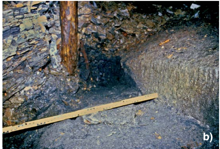
Abb. 62 Abkantung einer den Förderberg kreuzenden, älteren Strecke: a) Blickrichtung aufwärts b) Blickrichtung abwärts
