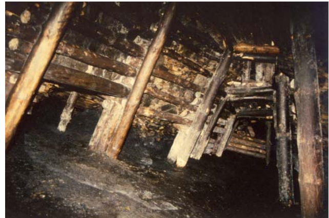
Abb. 75 Aufwältigung der Abbaustrecke nach Südwesten „q“
