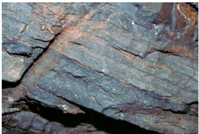
Abb. 61 Bohrlochpfeife in der Stollenfirste
