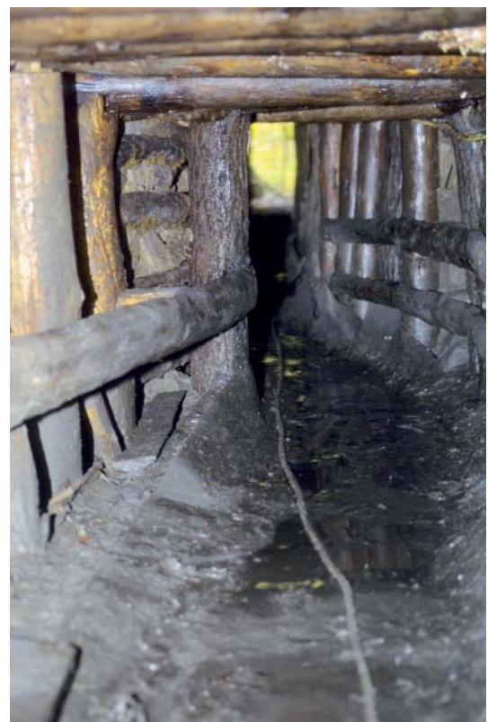
Abb. 111 Blick aus dem stark ausgebauten Förderstollen Schleifmühle zum Mundloch
