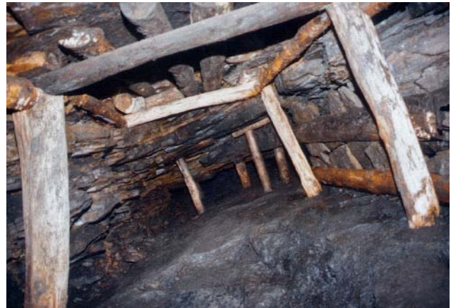
Abb. 85 Abbaustrecke nach Nordosten vor Ort mit dem Ende der Abkantung
