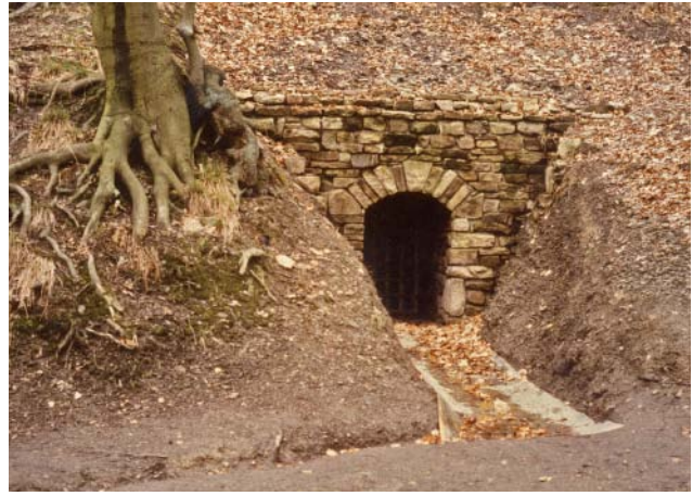
Abb. 71 Fertiggestellter Vorbau des Förderstollens Wittekind, 1991
