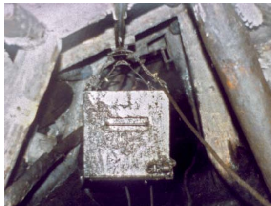
Abb. 175 Einschienenhängebahn in der „40-m-Strecke“
