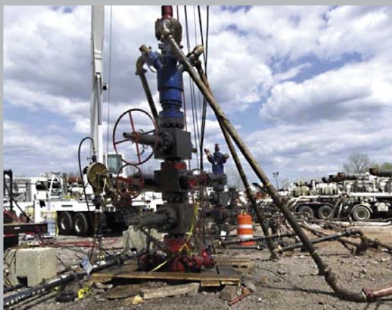
Unbefestigter Bohrplatz in Troy/ Pennsylvania, USA (aus NYSDEC 2011)
