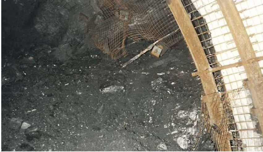
Abb. 15 Durch Gas-Kohlen- Ausbruch zerstörter Streckenausbau (aus KÖWING et al. 1991)
