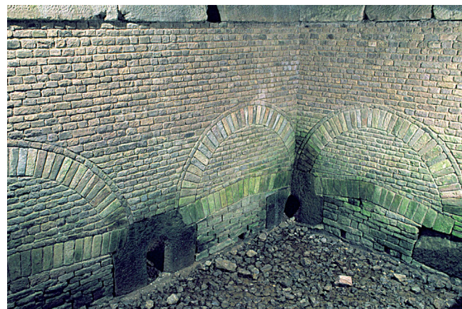
Abb. 53: Brunnenstube Klausbrunnen bei Mechernich-Kallmuth
