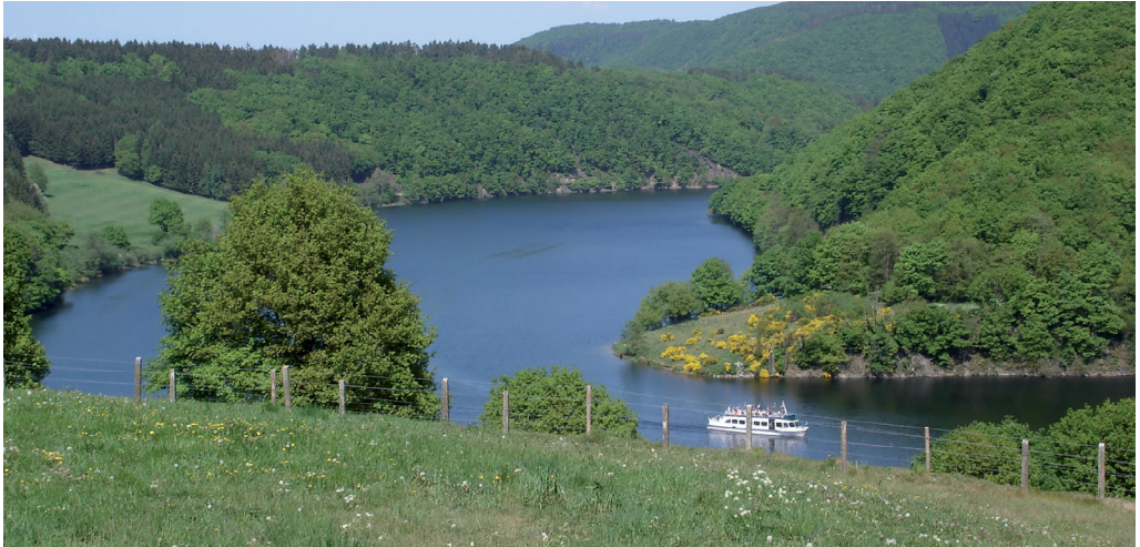
Abb. 68: Rurtalsperre (von Simmerath aus gesehen)
