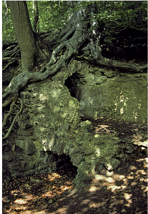
Abb. 55: Durchlass unter der Eifel-Wasserleitung bei Urft-Dalbenden
