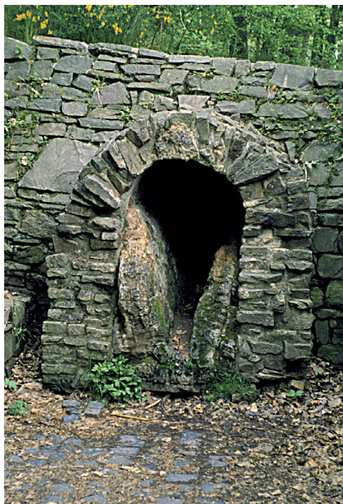
Abb. 58: Leitungsaufschluss mit 30 cm starken Kalksinterablagerungen bei Euskirchen-Kreuzweingarten
