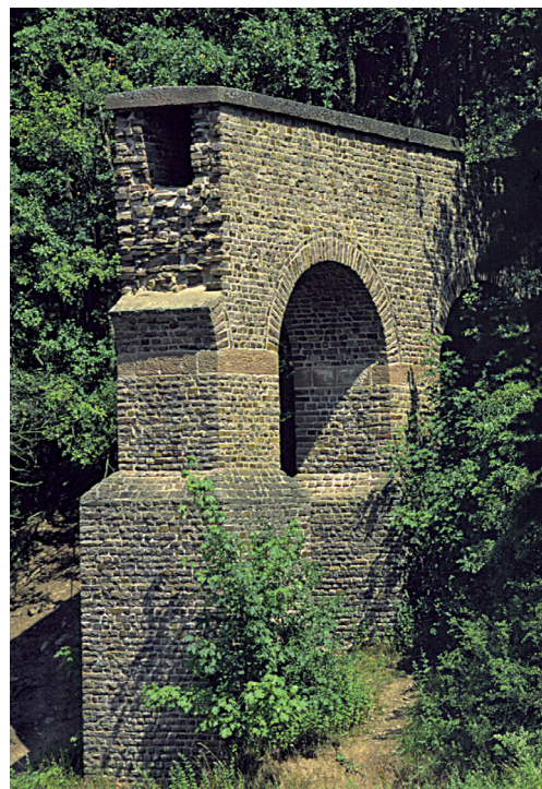
Abb. 54: Aquäduktbrücke bei Mechernich-Vussem
