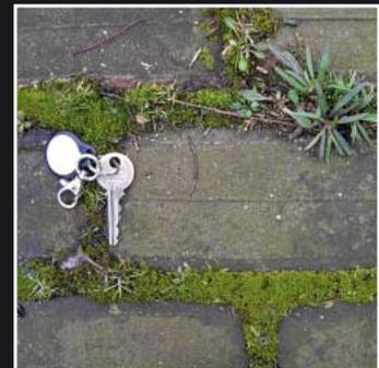
Wasser kann nur durch schmale Fugen in den Boden versickern
