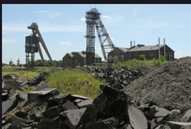
Böden alter Bergbau- und Industrieflächen sind meist schadstoffbelastet; eine neue Nutzung setzt die Sanierung voraus.
