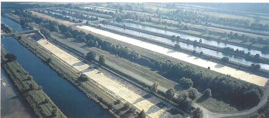
Abb. 42 Das Wasserwerk Haltern mit Filterbecken zur Grundwasseranreicherung durch Talsperrenwasser; Leistungsfähigkeit der Anlage: 106 Mio. m<sup>3</sup>/Jahr
