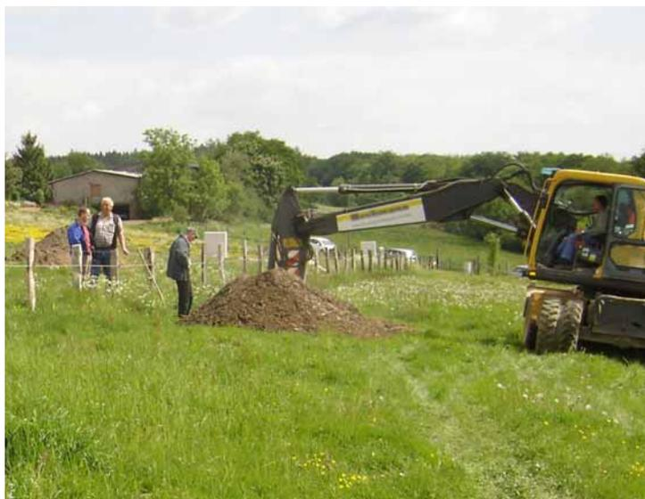
Aushub einer Schürfgrube zur Durchführung von Versickerungsversuchen, um die PFT-Drainage bei Scharfenberg zu prüfen.
