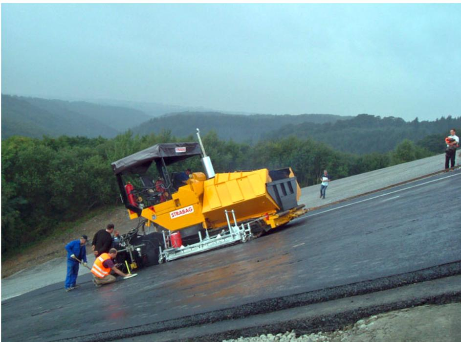
Asphaltabdichtung auf steiler Böschung
