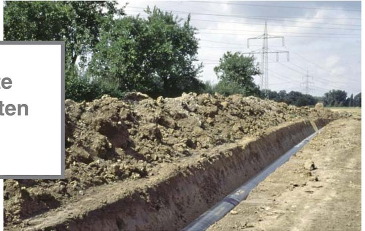
Im Straßen-, Eisenbahntrassen- und Leitungsbau sind Erdarbeiten bis in eine Tiefe von 2 m weit verbreitet. Ein wichtiges Hilfsmittel zur praktischen Ermittlung der Durchführbarkeit und der Kostenkalkulation solcher Arbeiten bietet die DIN 18300, nach der die anstehenden Locker- und Festgesteine in sieben Bodenklassen eingeteilt werden. Eine flächendeckende Karte der Bodenklassen liegt jedoch für Nordrhein-Westfalen nicht vor.
