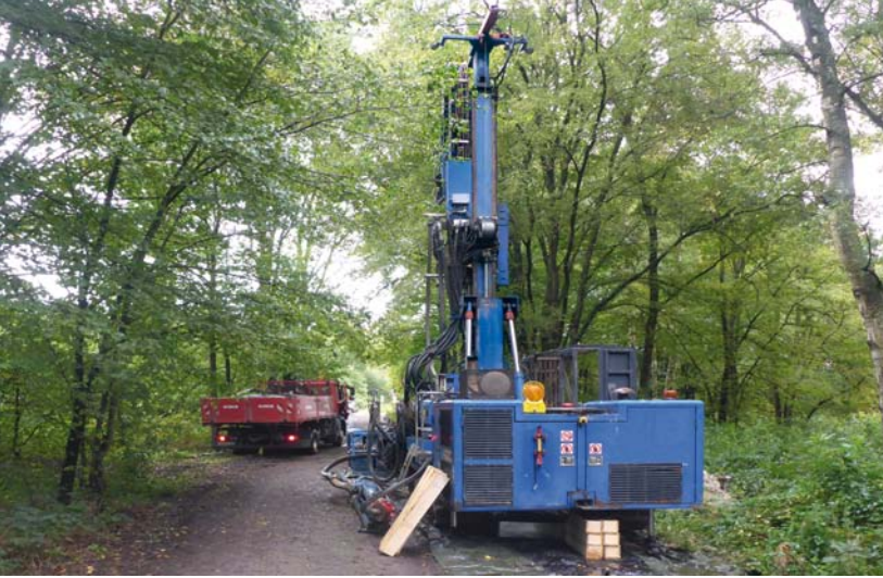
Bohrplatz auf dem Lintorfer Waldweg
