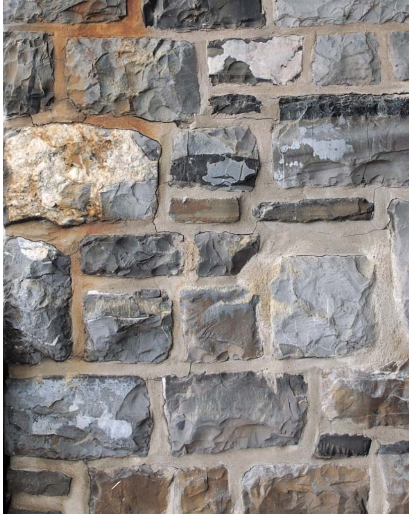
Grauwacke-Mauerwerk in der Sperrmauer des Möhnesees im Sauerland
