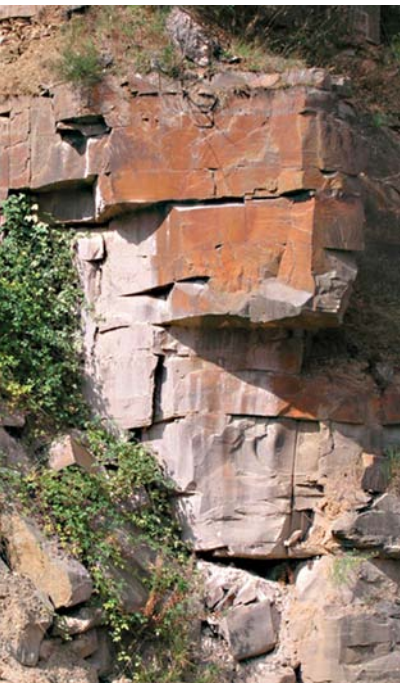
„Grauwacke“- Steinbruch in Lindlar
