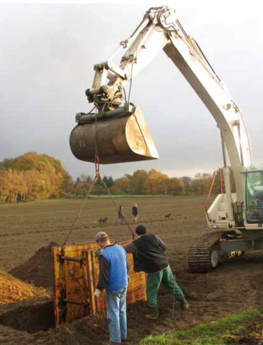
Anlegen einer Grube zur Begutachtung der Bodenverhältnisse
