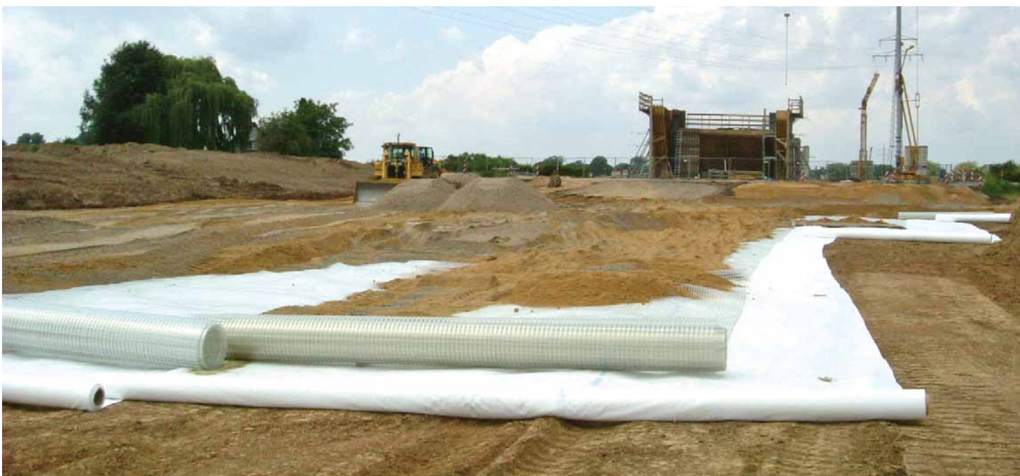
Dammschüttung auf Vlies und Geogitter
