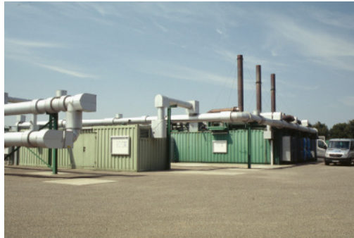
Abb. 3: Grubengasgewinnungsanlage im Bereich der ehemaligen Zeche Ewald in Recklinghausen
