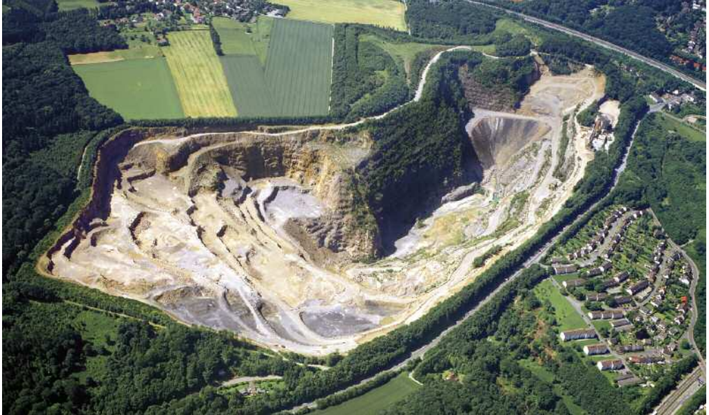
Abb. 51 Steinbruch Donnerkuhle. Werk Hagen-Halden (80) (Luftbild: Rheinkalk GmbH, Wülfrath)
