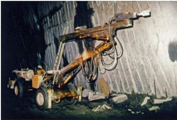
Abb. 39 Abbau des Fredeburger Dachschiefers mithilfe eines Abreißgeräts. Werk Fredeburg (64) (aus HEIB 1993)
