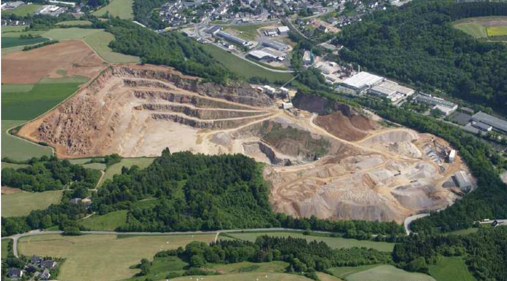
Abb. 58 Dolomitsteinabbau im Werk Grevenbrück (99) (Luftbild: Rheinkalk GmbH, Wülfrath)
